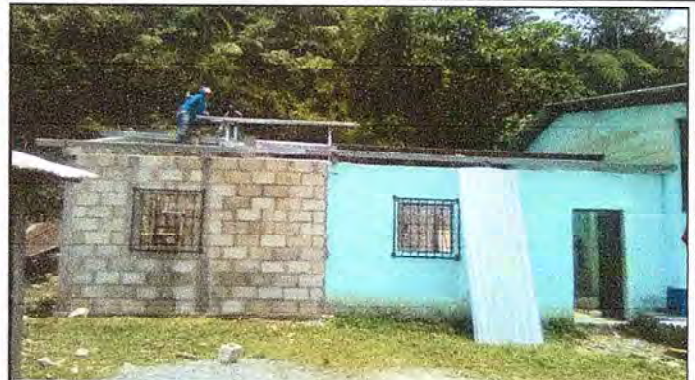
Foto 2: Proceso de la obra
