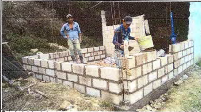
Foto 1: Inicio de la obra
