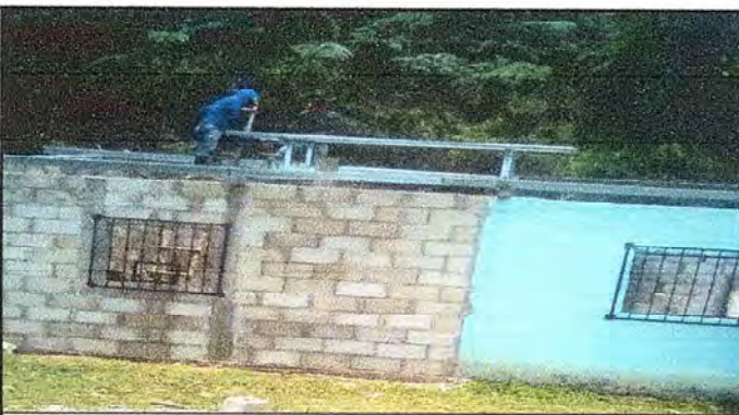
Foto 3: Inicio de entechado
